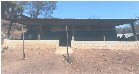
Foto 1: Mejoramiento, instalación de ventanas, puertas, techo, piso e hiladas de block para cerramiento de paredes del aula.
