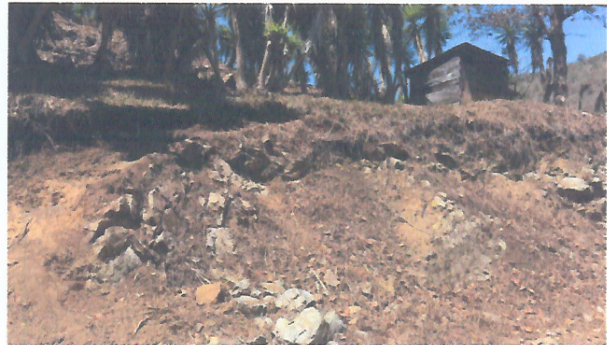
Foto 2: Mejoramiento de área de servicio sanitario con fosa séptica.
